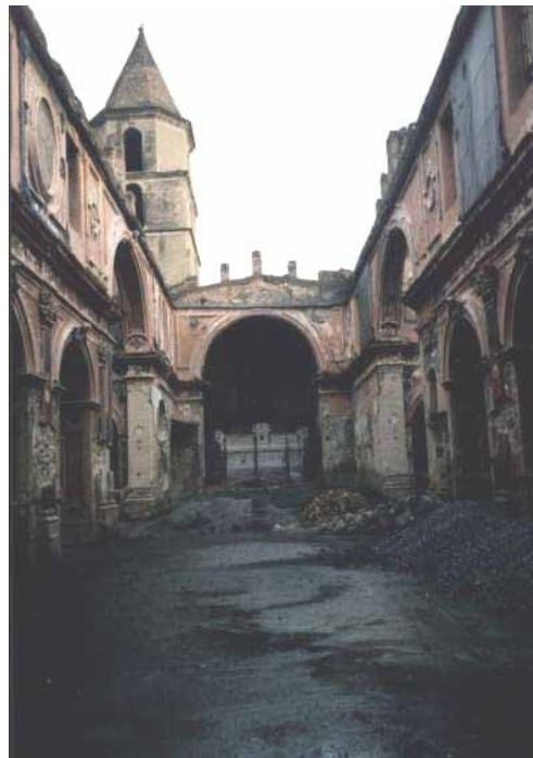
La cattedrale dopo l'incendio dell' '88
